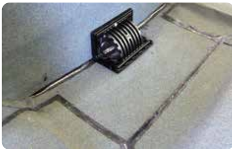
【アスファルト防水層施工試験】
