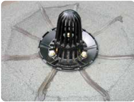
【アスファルト防水層施工試験】
