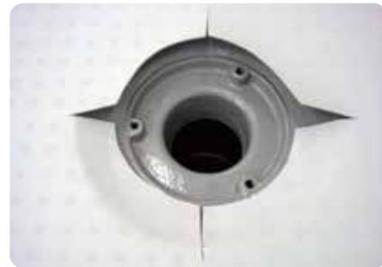
熱風機にて加熱して、塩ビシートと鑄鉄製本体の塩ビ粉体皮膜とを熱融着
