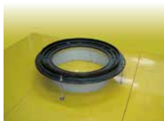
MK3を型枠に固定する。
