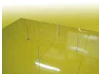
固定金具を釘で止め、レベルボルトを セットする。
