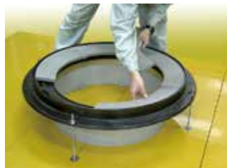
養生材を並べ、分割部分(内側)を クリップにて固定する。
