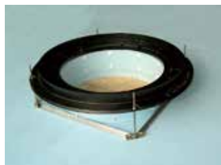
受枠を乗せレベルを確認後、ナット、 座金にて固定する。
