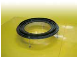
受枠をレベルボルトにセットし、ナット、 座金にて固定する。
