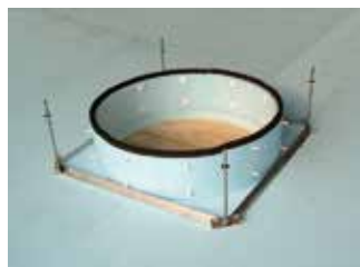
マンホール側用断熱材にバックアップ 材を、外周に合わせ貼り付ける。
