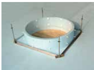
組み立てたマンホール側用断熱材を 開口に設置。(ナット、座金にて枠下まで のレベルを出しておく)
