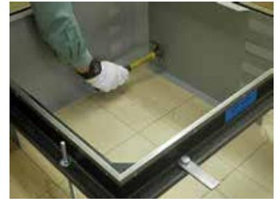
**5** 打込型枠を釘固定します。
