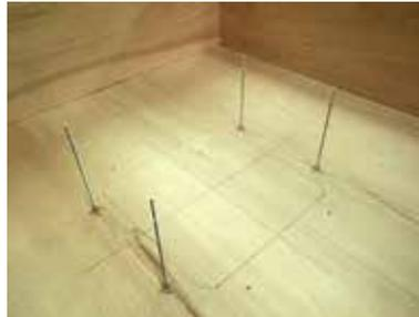
**2** レベルボルトをアンカー孔位置に釘止め固定します。
