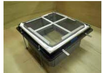
**8** 受枠の周囲にコンクリートが入らないよう養生材を押し込み取り付けを終了します。
