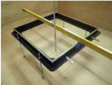
**3** 受枠をレベルボルトにセットし、ナットを回し仕上レベルに合わせます。
