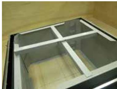
**7** 幅止め材の取付けを行います。打込型枠に幅止め材用の切込みがありますので、その位置にセットするようにしてください。
