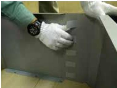
**6** 止め板を曲げ打込型枠を固定します。固定の際、打込型枠同士にスキマが出来ないように注意してください。
