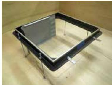
**4** 受枠に打込型枠を1枚ずつ設置します。セットの際に、下部開口と受枠内面に合わせて設置してください。
