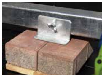
10 仕上材が吊上高さ調整板に当たり、蓋がぐらつかなくなるまでジャッキアップしてください。
