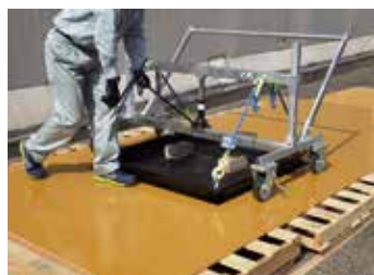
9 ハンドルを回してジャッキアップしていきます。
