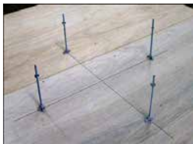
2 レベルボルトをアンカー孔位置に釘止め固定する。
