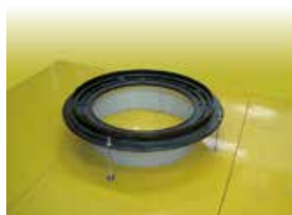
MK3を型枠に固定する。
