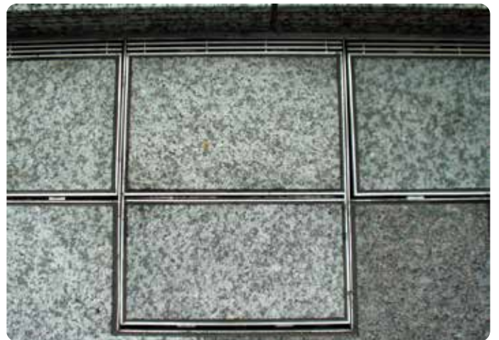
片側目地スリット
