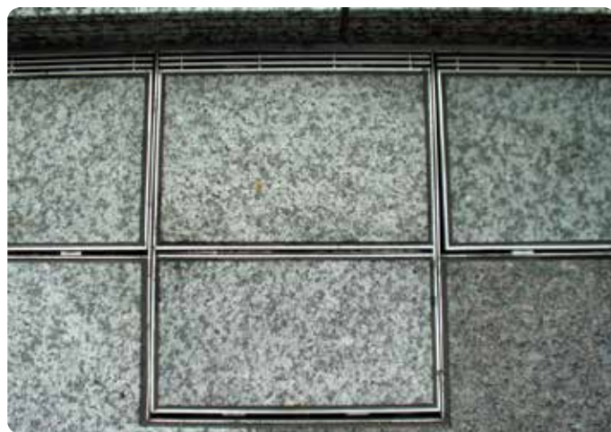
片側目地スリット
