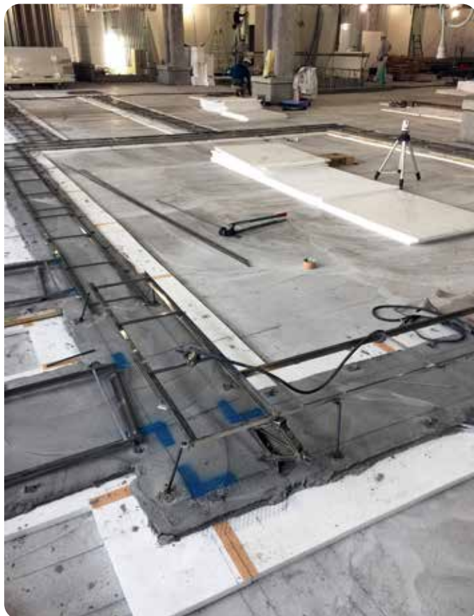
防振材がらみ受枠施工
