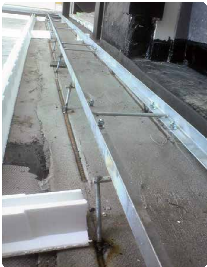
防水層がらみ受枠施工
