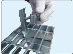
1・2. 固定金具の立ち上がり部から先に、グレーチングのスキマに入れる。
