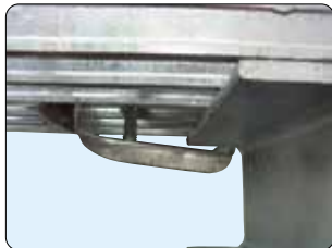
5. 固定金具の爪部を受材の下に入れる。
