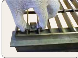
2. Uクリップのボルトにサドルクリップを写真および上図のように差し込む。
