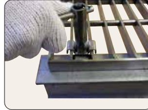
3. エンドプレートに写真上のようにつめの部分をしっかり押し付けながらUナットを締め付けていく。
