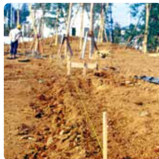
① 舗装仕上げ面の位置を墨出しします。
