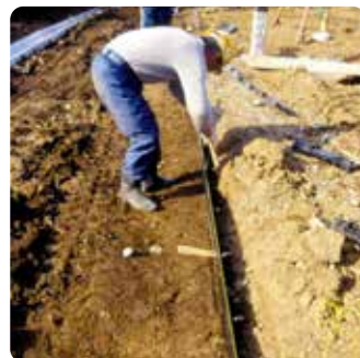
② 墨糸に沿ってアンカー打ちして位置を決めます。
