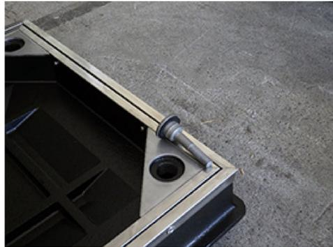
開閉鍵 MF-44 のマイナス部分を使用して、取手キャップボルトを取り外します。
