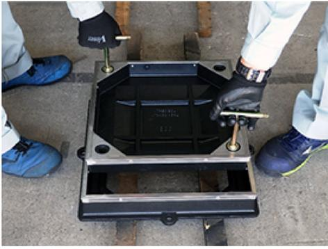
取手部分に開閉鍵(MF-44)をねじ込んだ後、蓋を引き上げ取り外してください。
