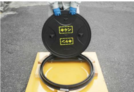
蓋を持ち上げ受枠の横棧(スタンド部)に蓋を落とし込みます。写真の様に「キケン」表示を開口側に向けて落としこんでください。
