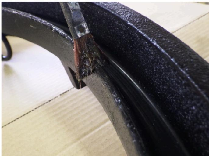
・ 接着剤を受枠立上り部分の先端に塗布後、刷毛等で塗り伸ばしてください。
