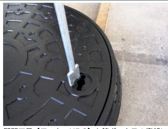
開閉工具【フック：MF-3】を錠ボックスの底部に差し込みます。
