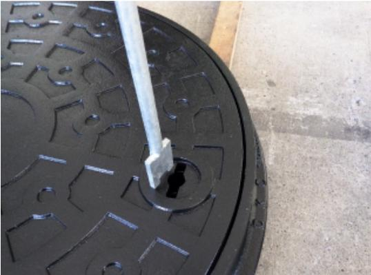
開閉工具【フック：MF-3】を錠ボックスの底部に差し込みます。
