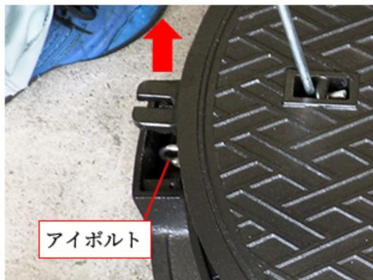
蓋のボックス側を先に持ち上げアイボルトから抜き上げます。
