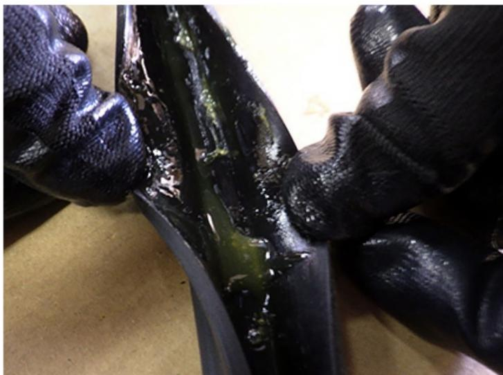
・パッキンは受枠の立上りに差し込む形状になっています。接着剤はパッキンの内面に塗布します。
