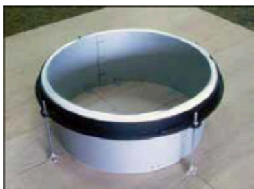
6. 受枠周囲の溝にコンクリートが入らないよう養生材を押し込み取り付けを終了します。
