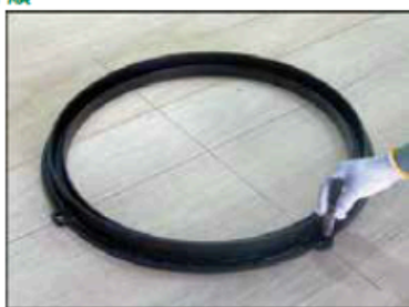
1. 受枠を施工位置に置きアンカー孔位置に印を付ける。
