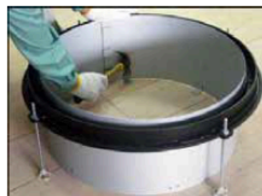
5. 固定座に釘打ちをし打込型枠を固定する。
