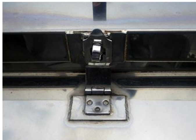
施錠部拡大写真
