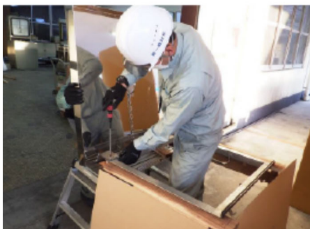
4. 受枠にカバーのヒンジを M8 皿小ねじで左右の合計4ヶ所固定します。
