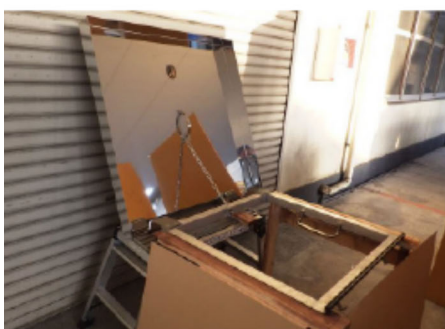
5. 受枠にクサリを固定し完了です。
