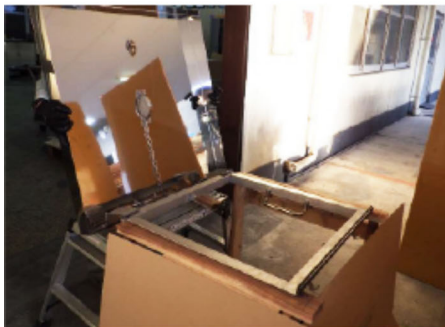
3. 受枠にカバーのヒンジを合わせます。
