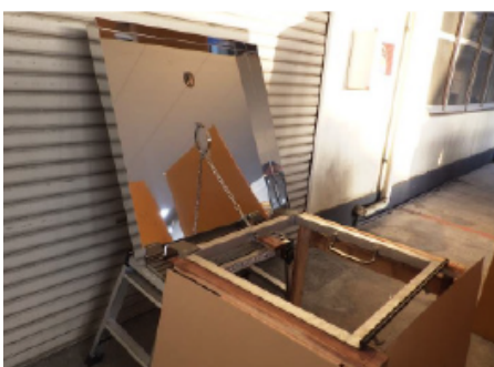
5. 受枠にクサリを固定し完了です。
