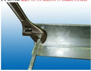
2-3 両サイド同様にして外し、外した後はバリがある場合はベビーサンダーにて除去し補修塗装をする。
